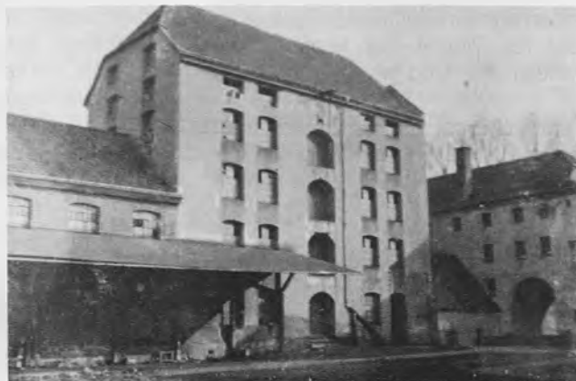
Aus den Jahren 1783/84 stammt dieser Bau, der als erstes ausschließlich für Fabrikationszwecke errichtetes Gebäude in Deutschland gilt und deshalb jetzt als Industriedenkmal ausgebaut wird.
