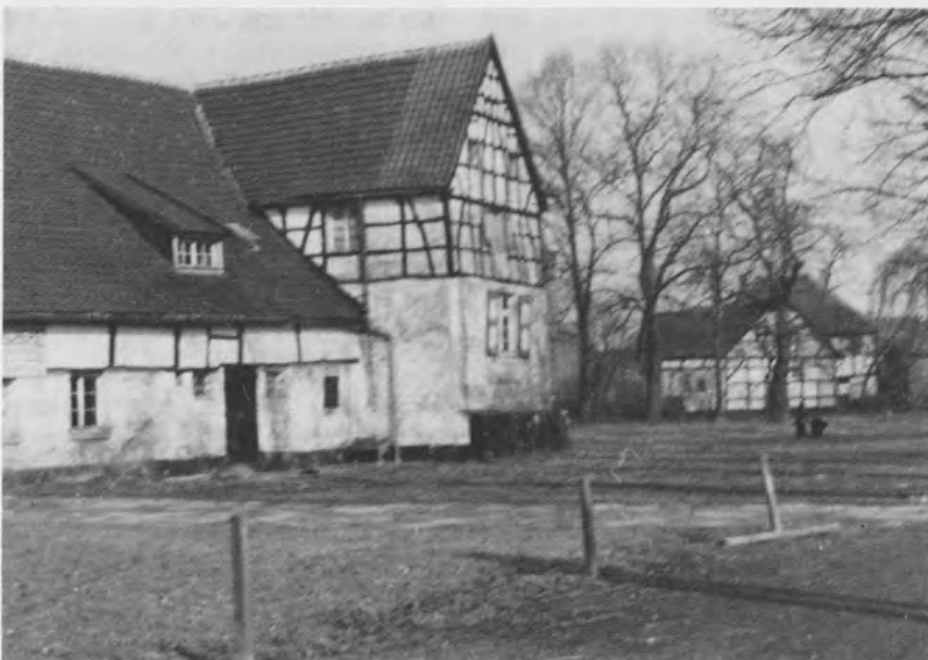
Gut Hinüber, abgerissen 1956.
